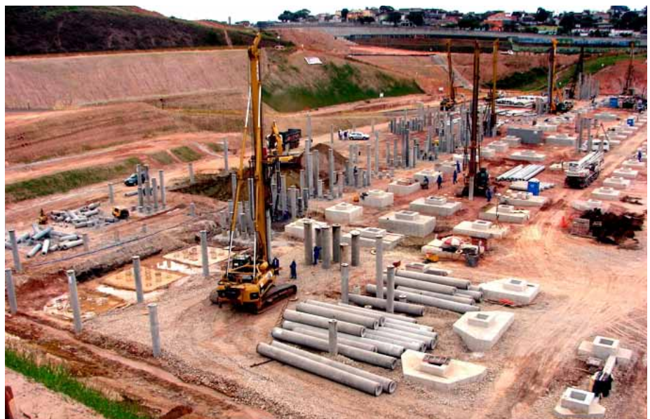
VISITA A UNA OBRA EN FASE D'ESTRUCTURES A SÃO PAULO
